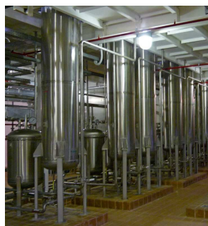
Рис. 9.3. Внешний вид сортировочного отделения с классическими угольными колоннами
