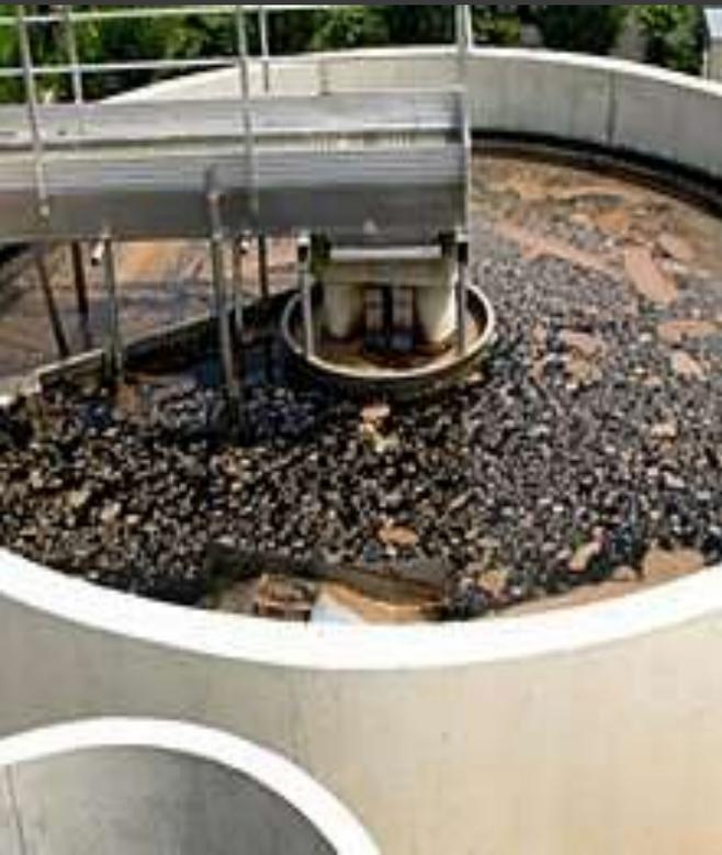
Устройство для очистки сточных вод активированным углем
