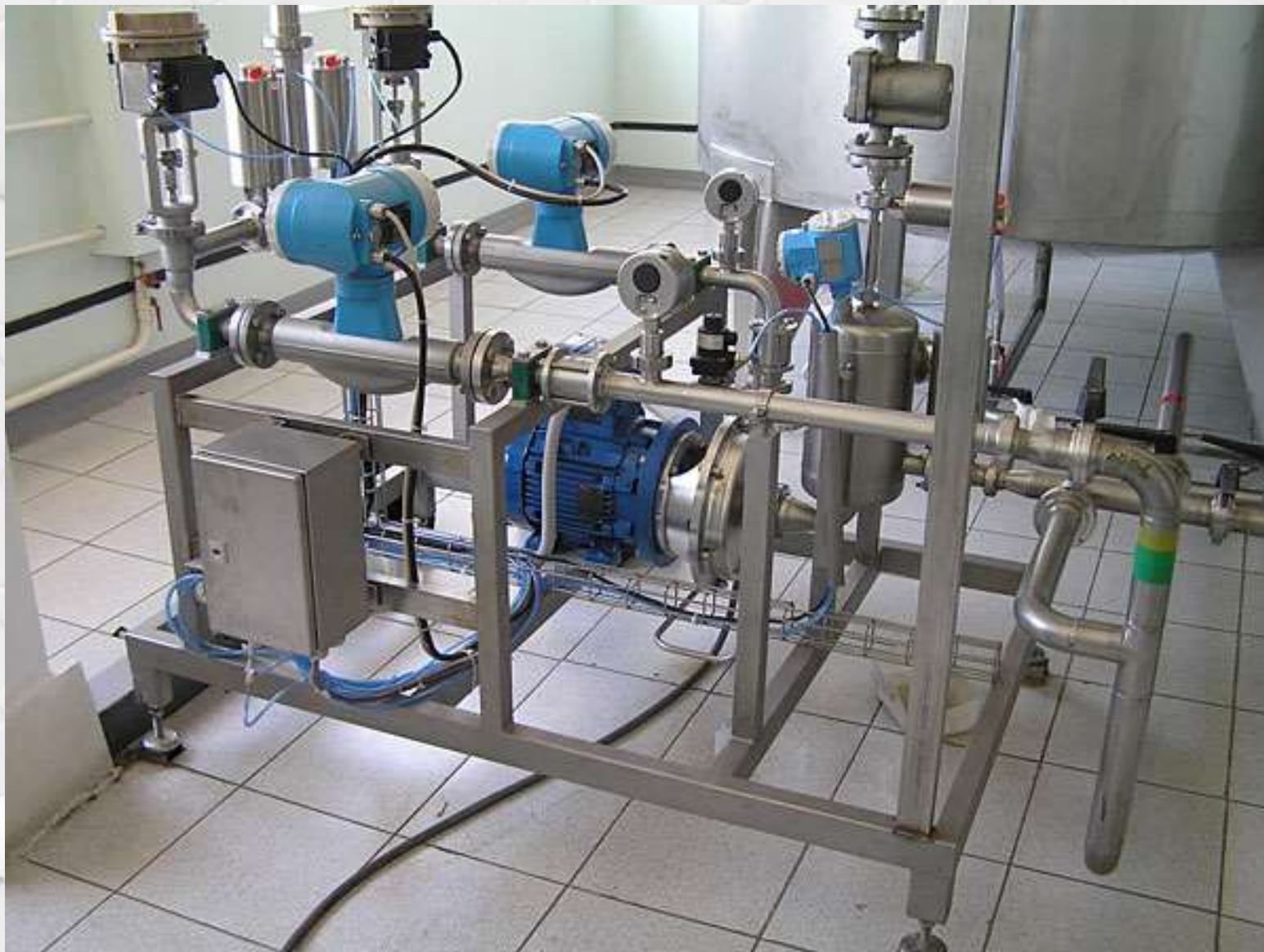
Установка непрерывного смешивания фирмы Diessel на ООО «Русский рецепт и Ко» (турбулизация потоков в трубе-смесителе)
