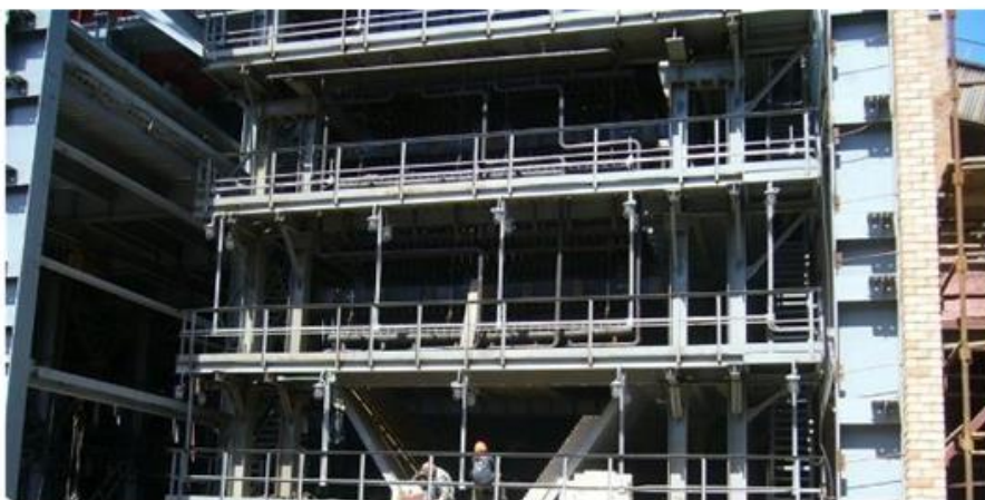
Рисунок 1.5 – Котел-утилизатор с термосифонами за вельц-печью «Усть-каменогорского металлургического комбината (Казахстан): а) вид сверху: в «рассечку» между радиационной и конвективной группой термосифонов установлен воздухоподогреватель; б) вид с торца (котел-утилизатор в процессе монтажа)
