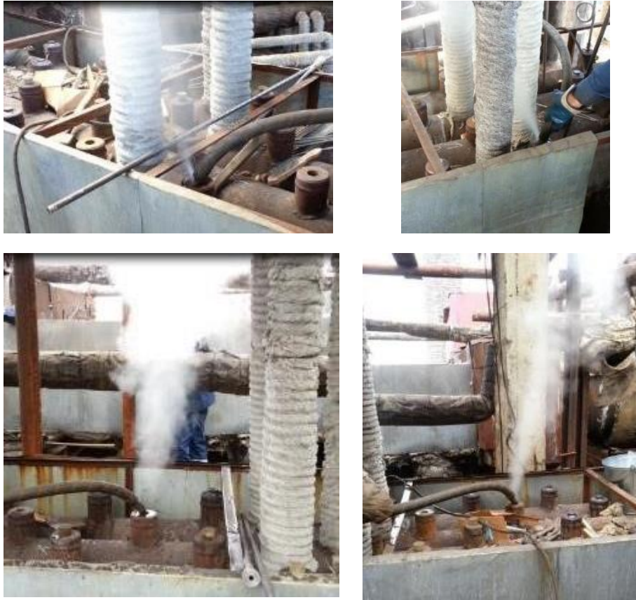
Рисунок 5.1 – Неконтролируемые потери теплоносителя при заполнении термосифонов по алгоритму ОАО «Уралэнергоцветмет»
