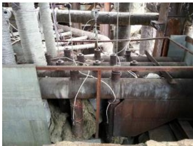
Рисунок 2.14 – Общий вид установленных датчиков
